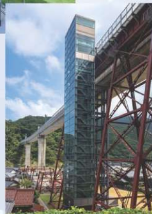
余部クリスタルタワー
